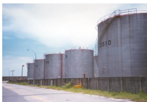
碳鋼儲槽(750KL-3,000KL)
